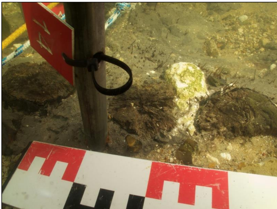
Figure 78 : Exemple de l'utilisation d'une pierre pour caler deux pieux entre eux.
